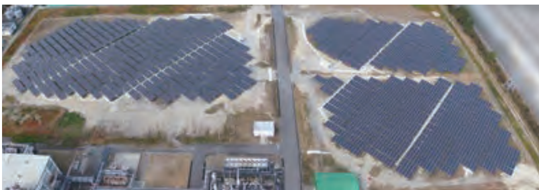
小名浜 太陽光発電設備
